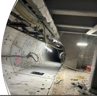
Conduit Under Construction
